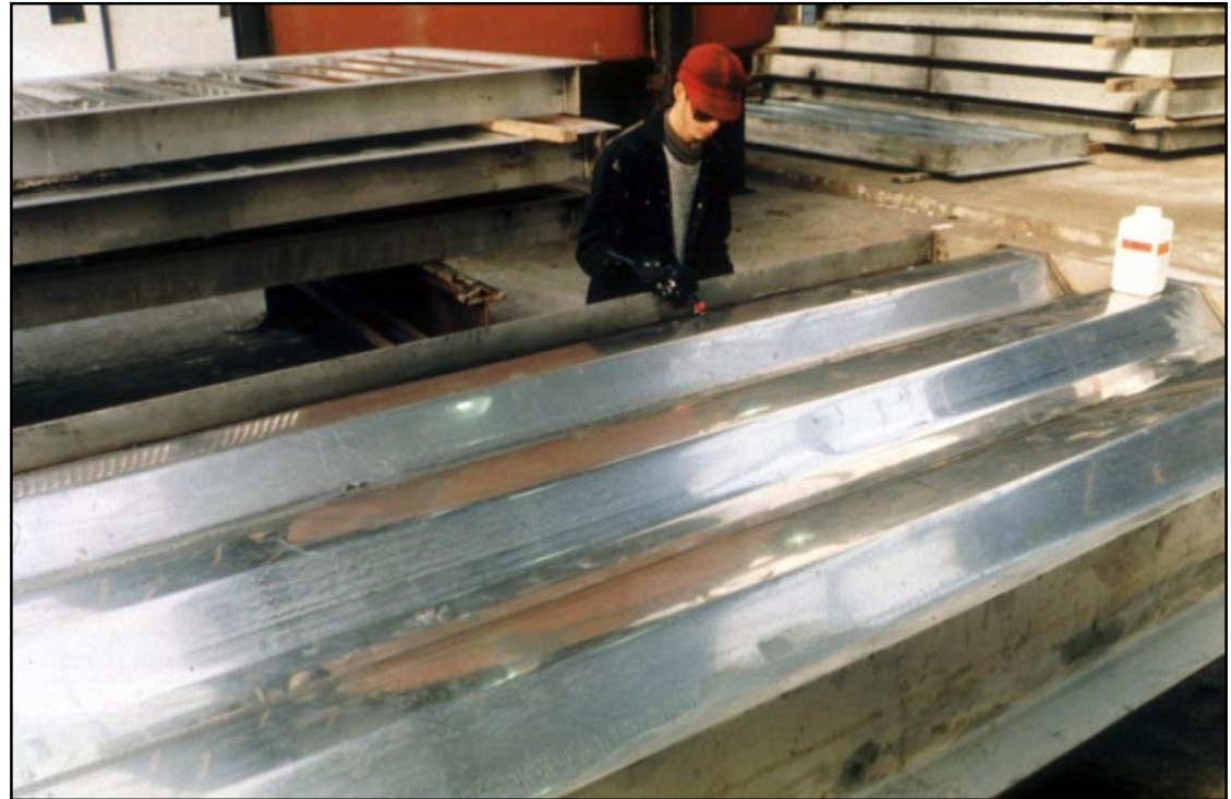
Fabricación del muro trapezoidal resistente a explosiones de la obra muerta de una plataforma offshore
