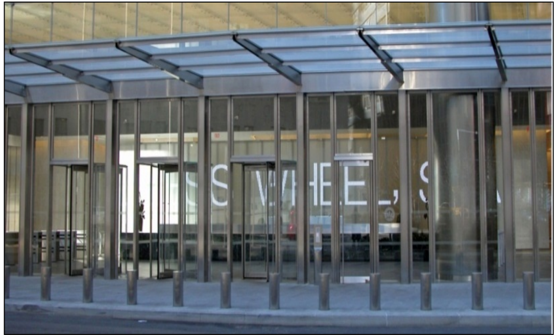
Porche con pilares resistentes a explosión en la entrada del Seven World Trade Centre, Nueva York
